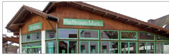
Nur äußerlich im Dörrschenschlaf: Die Projektgruppe „Dorftreff“ arbeitet fleißig im Hintergrund, damit in den Räumlichkeiten des früheren Raiffeisenmarktes wieder Leben einkehren wird.
