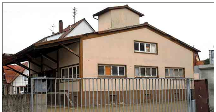
Das alte Raiffeisen-Agrargebäude: Experten schlagen den Abriss vor. Foto: Reiner Merz
